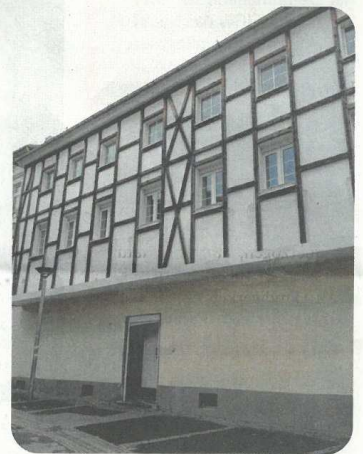
So tristlos sah die Fassade aus, bevor sich die IGW des Objektes angenommen hat.
